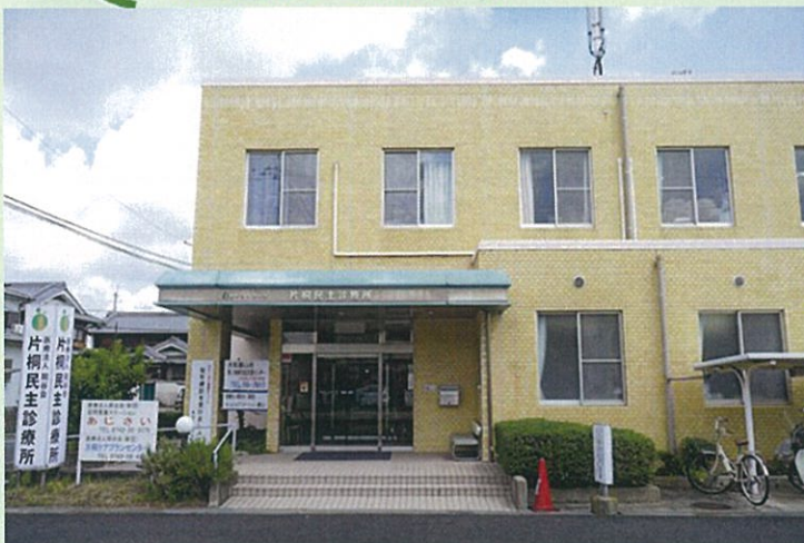
外観 片桐民主診療所(内科・整形外科・泌尿器科)と併設
